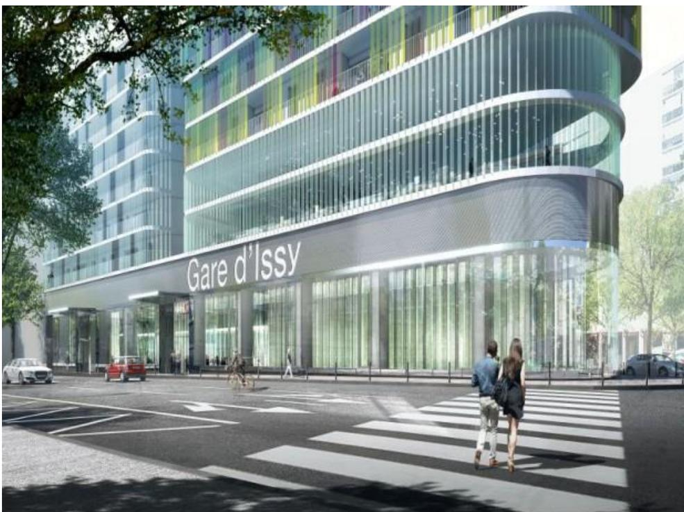
Côté architecture, "l'émergence de la structure ne sera pas positionnée à l'aplomb de la 'boîte' comportant les escaliers mécaniques, les quais et les voies mais sera décalée." S'agissant des matériaux, l'enveloppe sera entièrement conçue en verre, le plafond en aluminium ou inox sera réfléchissant et des lames de verre brisé
